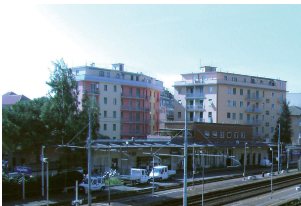
I due grandi edifici di piazza Martiri della Libertà.
