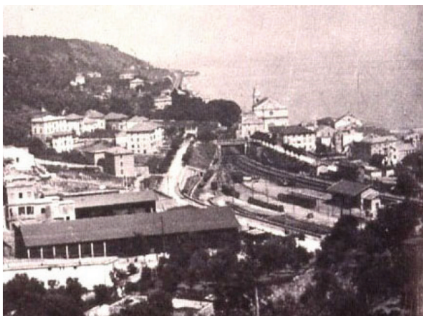
Costruito il cavalcavia ferroviario nascono un decina di case.
