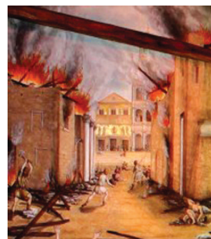
L'incendio di Cogoleto.
