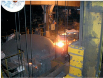
Forno mantenimento ASEA.
