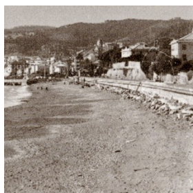
Il muraglione lungo la ferrovia.
