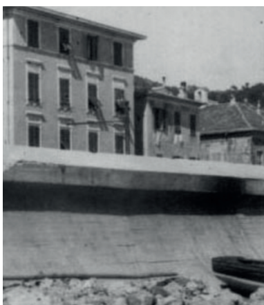
Prime decisioni: Demolire muro tedeschi
